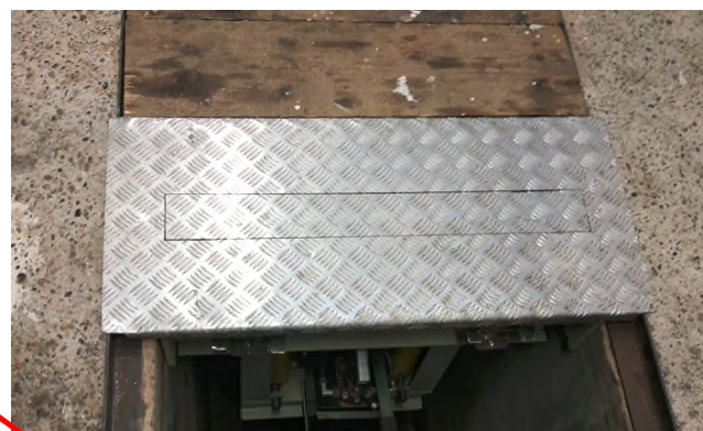
Fosse rebouchée, quasi lisse
